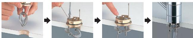
ユニット上面から施工できるので、シンクの下にもぐり込まず立ったままでの簡単・ラクラクな施工ができます。
