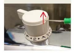
切替ハンドルを上方向に取り外 し、切替カラーを右側にずらし ます。
