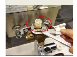
7 ねじ部の切り欠きにマイナスド ライバー等をかけ、切替弁を上 方向に持ち上げ取り外します。 交換部品は逆の手順で組み付 けます。
