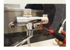
2 キャップをマイナスドライバー (小)で切り欠き部にさし、上方 向に取り外します。
