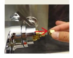
5 ストップカラーをプラスド ライバー(小)で時計と 反対周りに回し、取り外 します。
