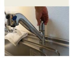
6 吐水口を支えて、モン キーレンチを引っ掛け、 時計周りで回し、固定 ナットを締め付けます。
