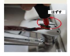
2 モンキーレンチを引っ掛けて時計と反対周りで回し、固定ナットを外します。
