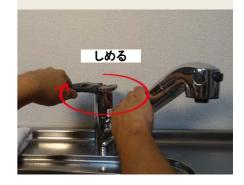
7 レバーハンドルを嵌めて、ビスを回し、締め付けます。湯水の表示キャップをはめて完了。
