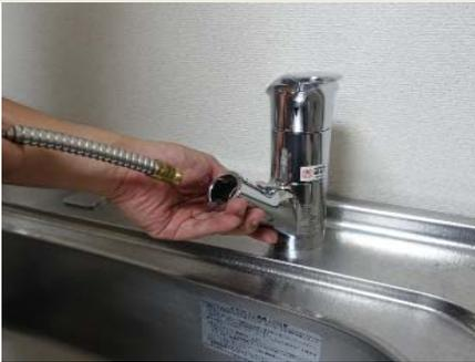
11 新しいシャワーホースを吐水口に挿入します。交換部品は逆の手順で組み付けます。
